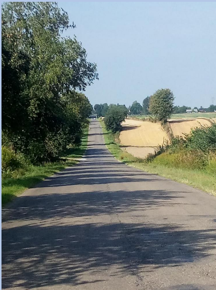
Gmina Szastarka DP 2702L
