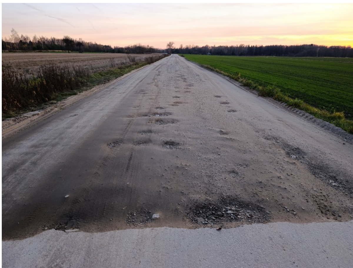
Rycina 18. Fragment trasy o nawierzchni żwirowej
