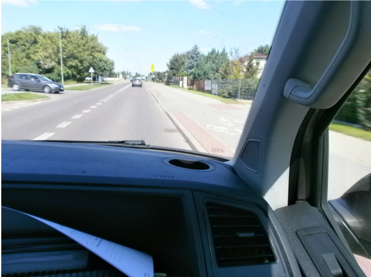
Rycina 10. Nieprawidłowa niweleta i zmienione nawierzchnie na wjazdach do posesji.
