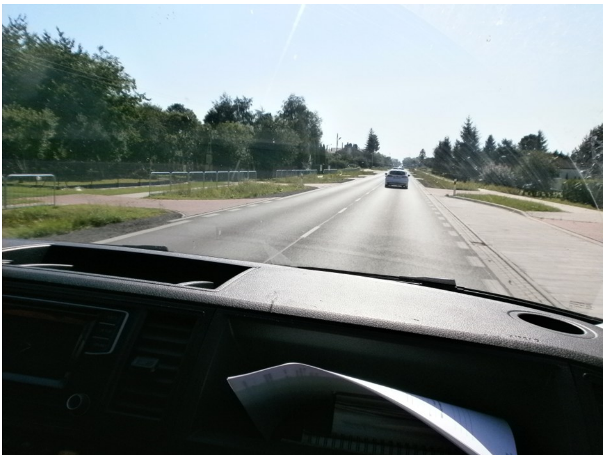
Rycina 14. Niepotrzebne bariery wzdłuż drogi pieszo-rowerowej.
