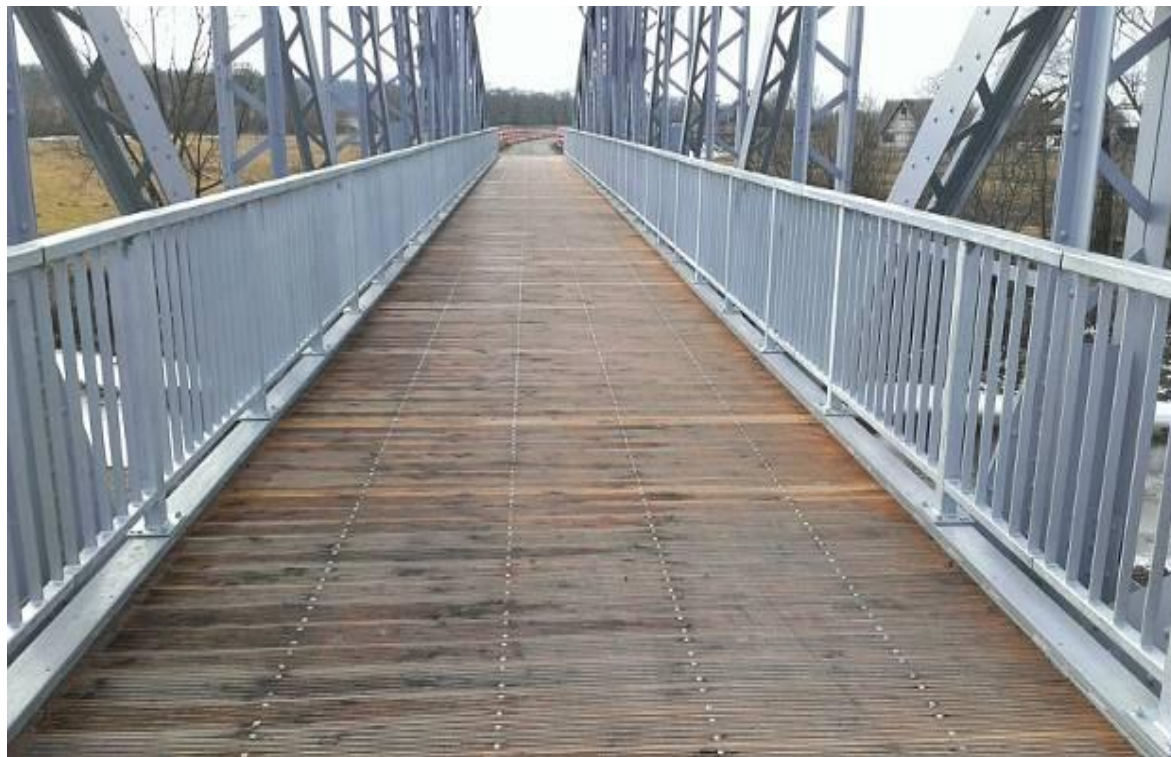
Ilustracja 40. Adaptacja mostu kolejowego na kładkę rowerową
