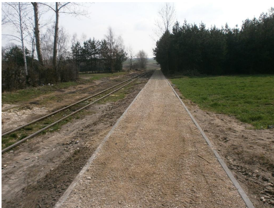
Ilustracja 6. Trasa rowerowa obok linii kolejowej wąskotorowej (zastosowano zły rodzaj nawierzchni)
