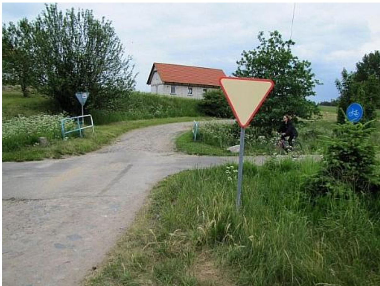
Ilustracja 19. Przykład przejazdu dla rowerzystów na skrzyżowaniu drogi dla rowerów z drogą ogólnodostępną z pierwszeństwem przejazdu drogi dla rowerów
