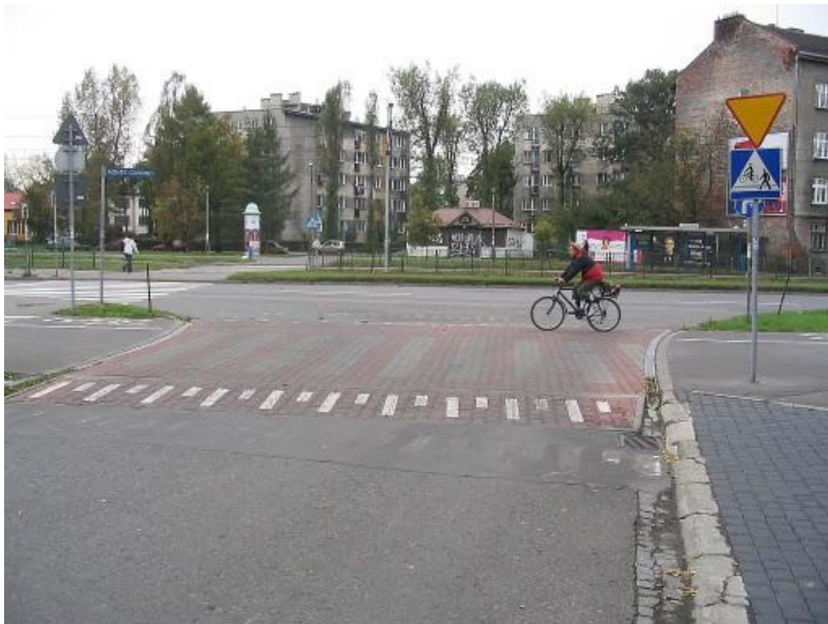
Ilustracja 18. Przejazd dla rowerzystów prowadzony grzbietem płytowego progu zwalniającego poprawia BRD
