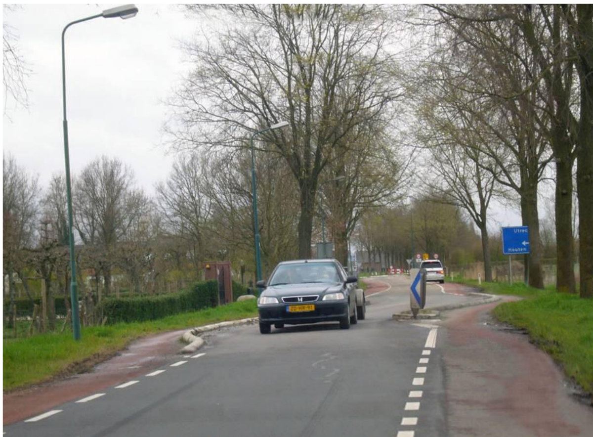
Ilustracja 15. Szykana w postaci dwóch odwrotnych łuków poziomych (odgięcie toru jazdy)
