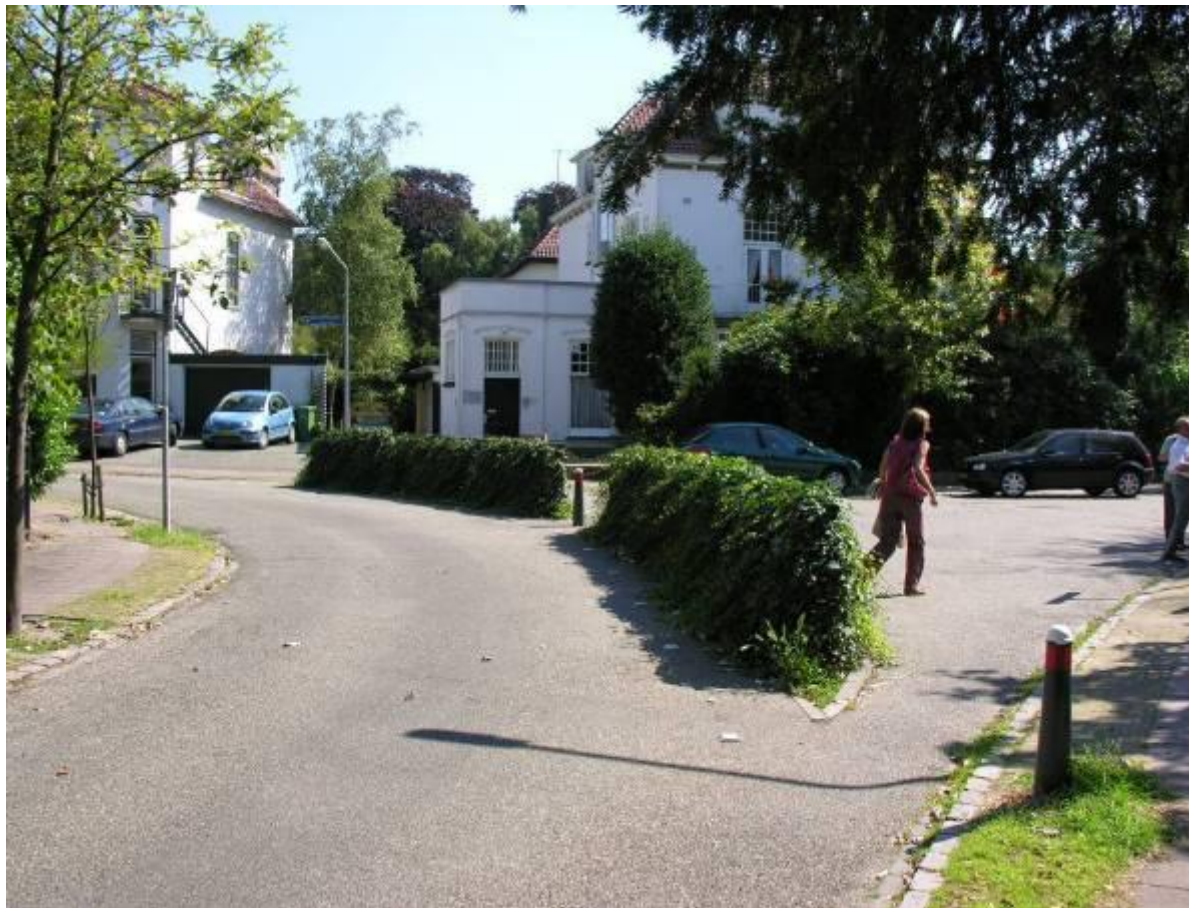
Ilustracja 9. Jedna z form rozcięcia skrzyżowania uniemożliwiającego przejazd samochodem a umożliwiającego przejazd rowerem
