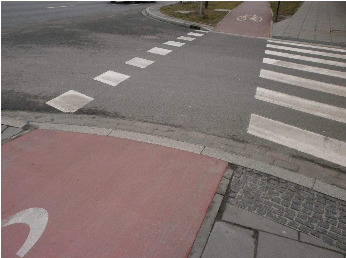
Ilustracja 17. Jednostronne oznakowanie przejazdu dla rowerzystów zlokalizowanego bezpośrednio przy przejściu dla pieszych
