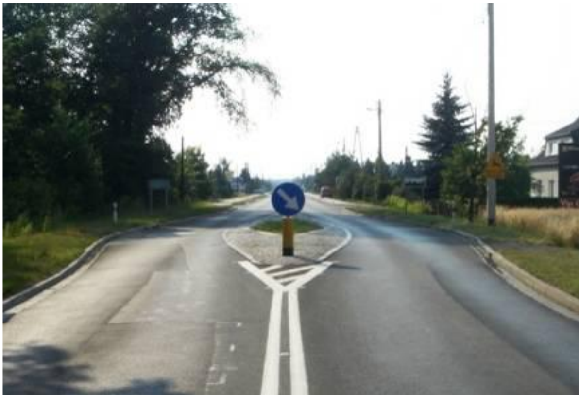
Ilustracja 14. Przykład „bramy wjazdowej” do obszaru zabudowanego – odgięcie toru jazdy wymuszające spowolnienie
