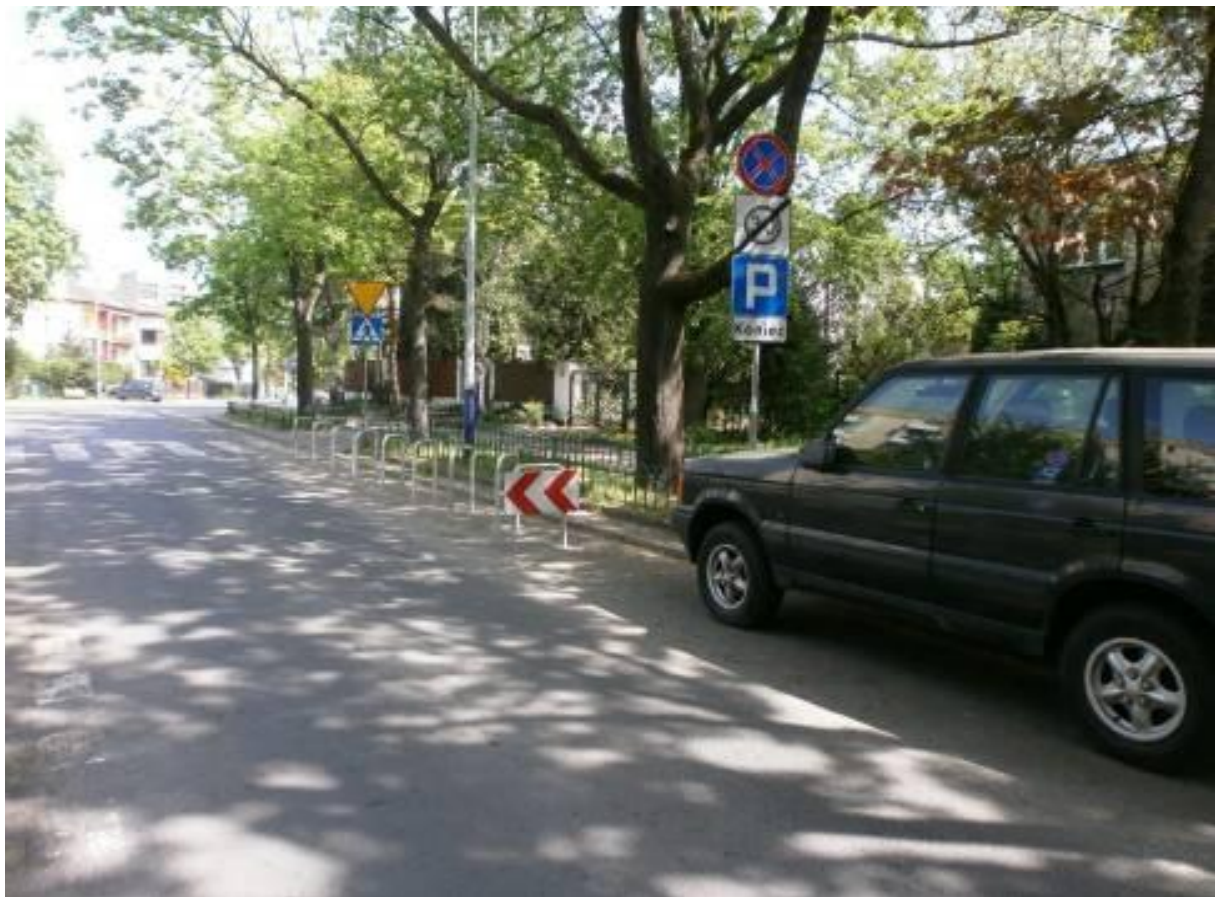
Ilustracja 11. Skracanie zatok parkowania i zwężenie przekroju jezdni ulicy przed skrzyżowaniami stojakami rowerowymi
