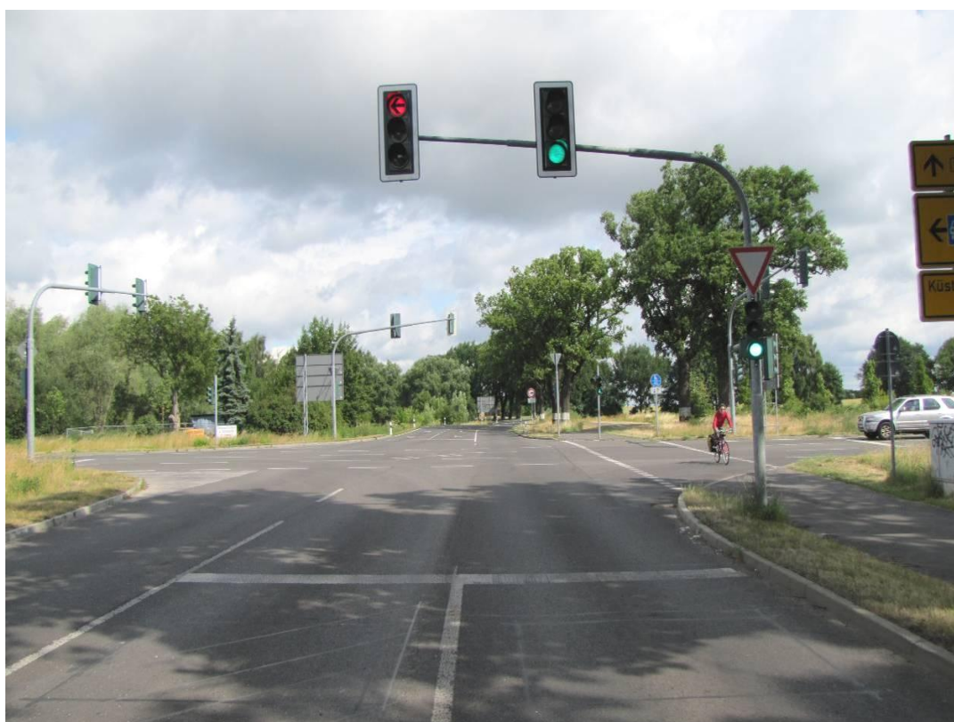
Ilustracja 24. Prawidłowe przeprowadzenie trasy rowerowej przez skrzyżowanie
