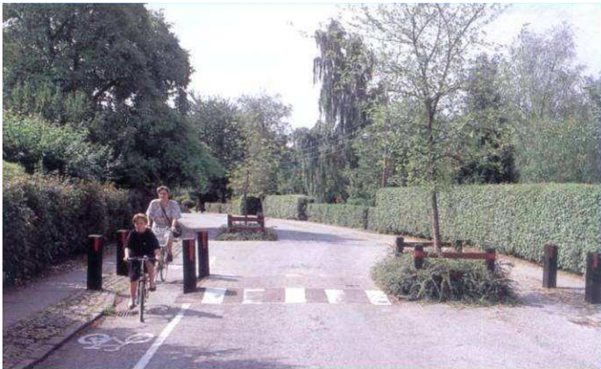
Ilustracja 8. Szykany mają uspokoić ruch samochodowy i ułatwić przejazd rowerzystom
