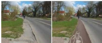
Źyc. 14 Przykładowa inwestycja - droga dla rowerów poza jezdnią na terenie zabudowanym (Źyc 1d)
