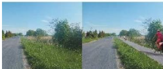
Źyc. 16 Przykładowa zmiana organizacji istniejącego układu drogowego - ciąg rowerowy poza drogą (dla odcinków o dużym natężeniu ruchu pojazdów) (Źyc 2a)
