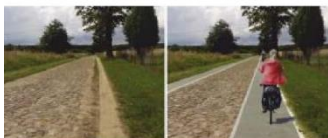
Źyc. 18 Przykładowa zmiana organizacji istniejącego układu drogowego - ciąg rowerowy przy drodze z brukowcem (Źyc 3b)
