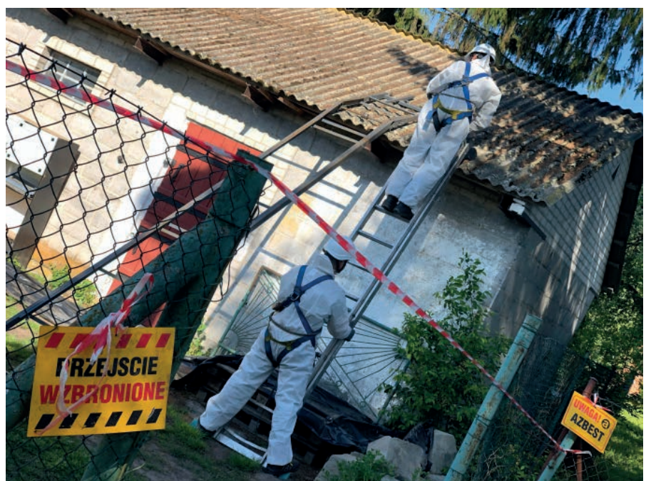
Usuwanie azbestu w ramach projektu „System gospodarowania odpadami azbestowymi na terenie województwa lubelskiego”, fot. archiwum UMWL
