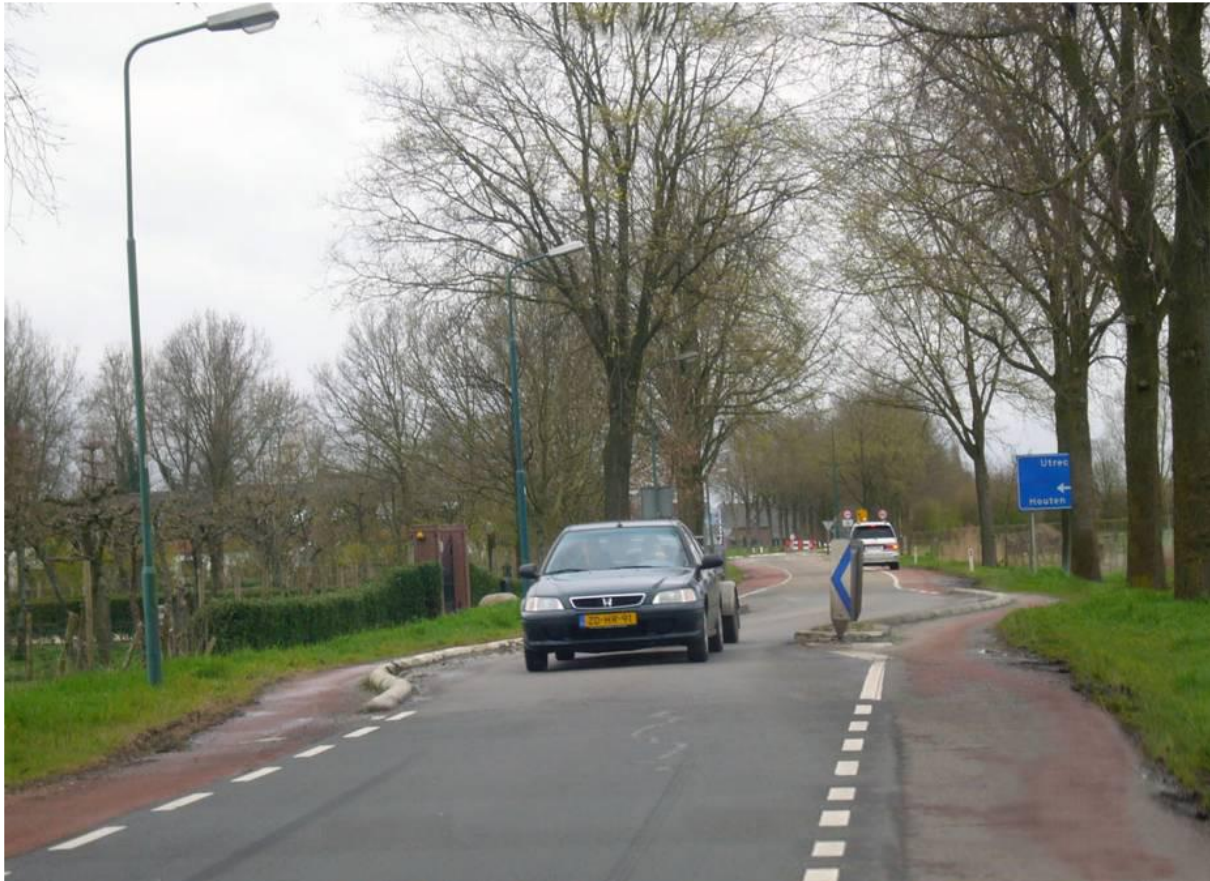
Ilustracja 14. Szykana w postaci dwóch odwrótnych łuków poziomych (odgięcie toru jazdy)
