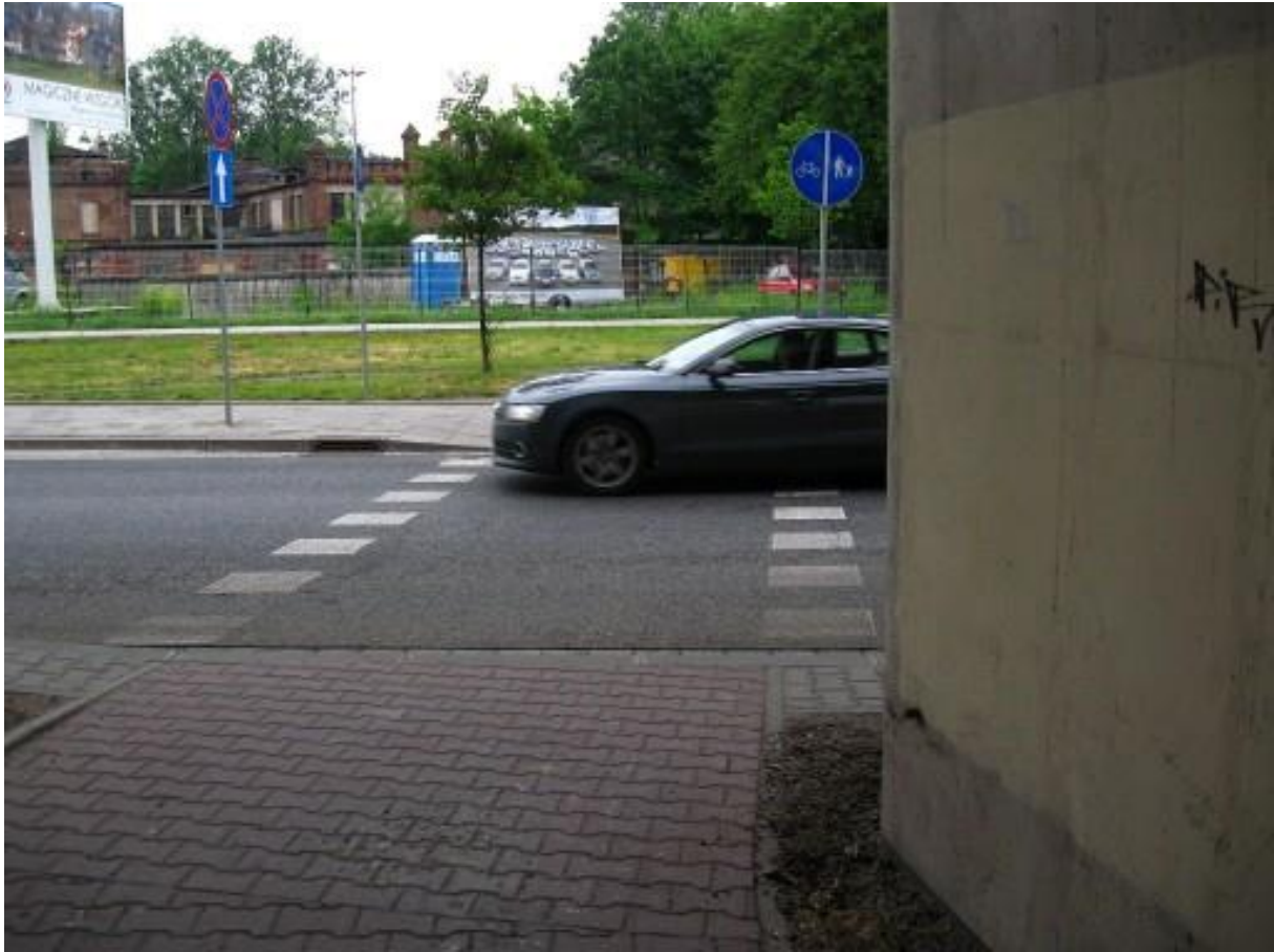
Ilustracja 21. Brak widoczności przed przejazdem dla rowerzystów – konieczny znak B-20 „stop”
