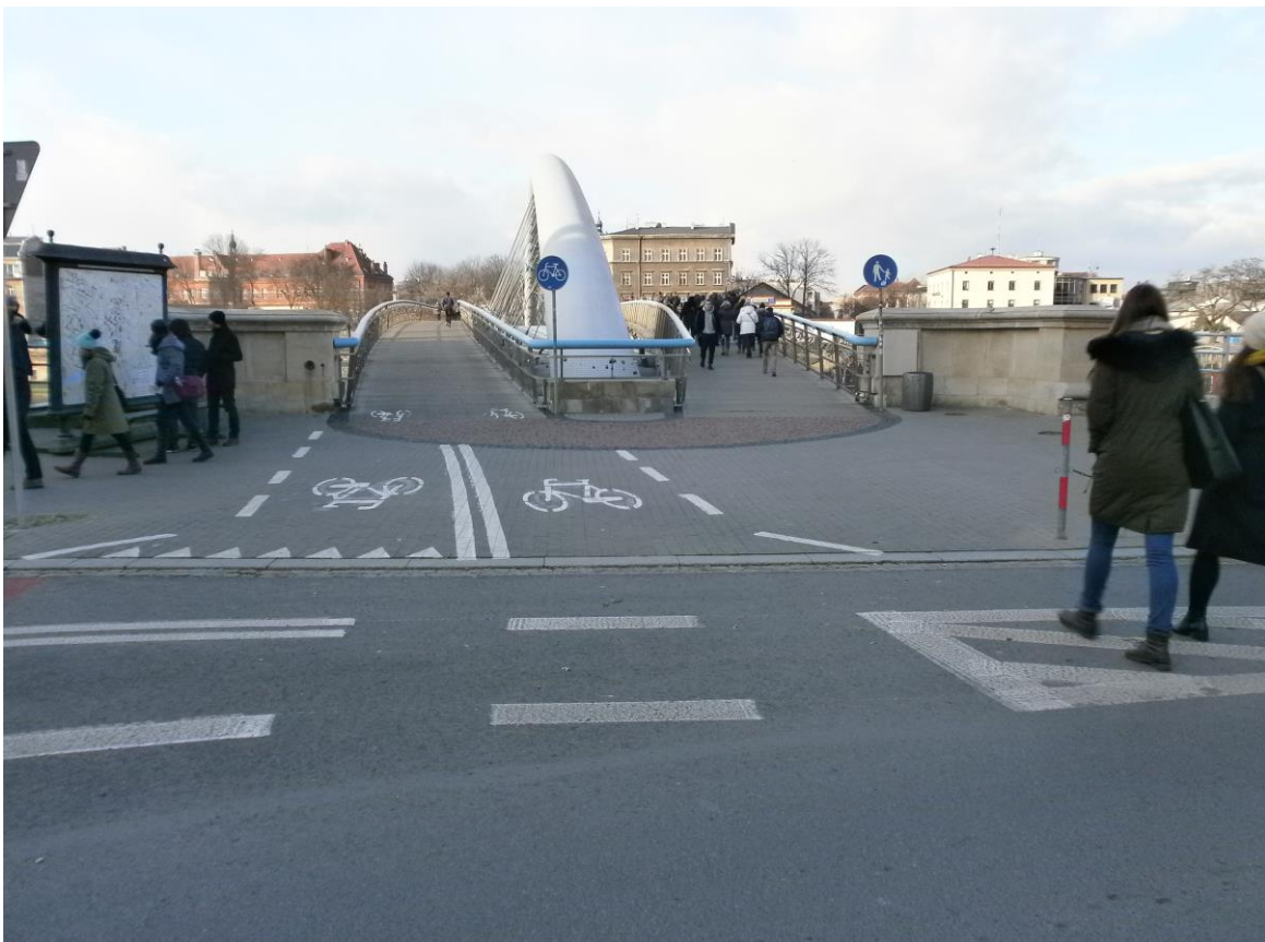
Ilustracja 39. Kładka Bernatka przez Wisłę w Krakowie z oddzieleniem ruchu rowerowego od pieszego
