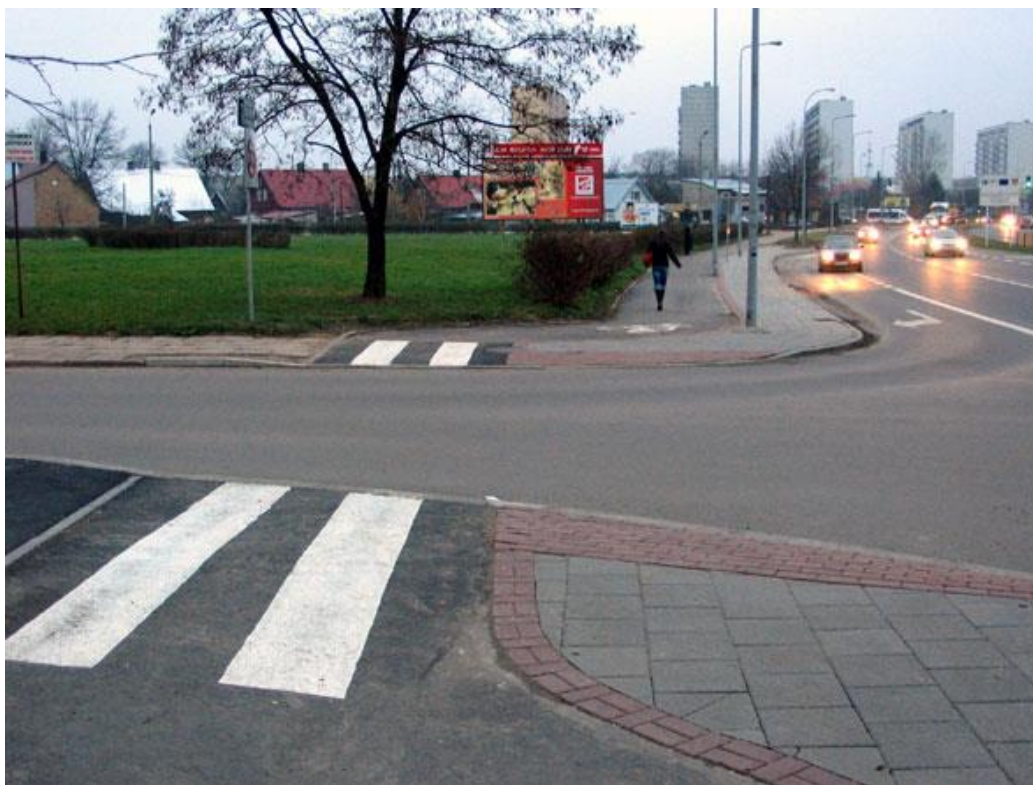
Ilustracja 23. Nieprawidłowe odgięcie trasy rowerowej na skrzyżowaniu
