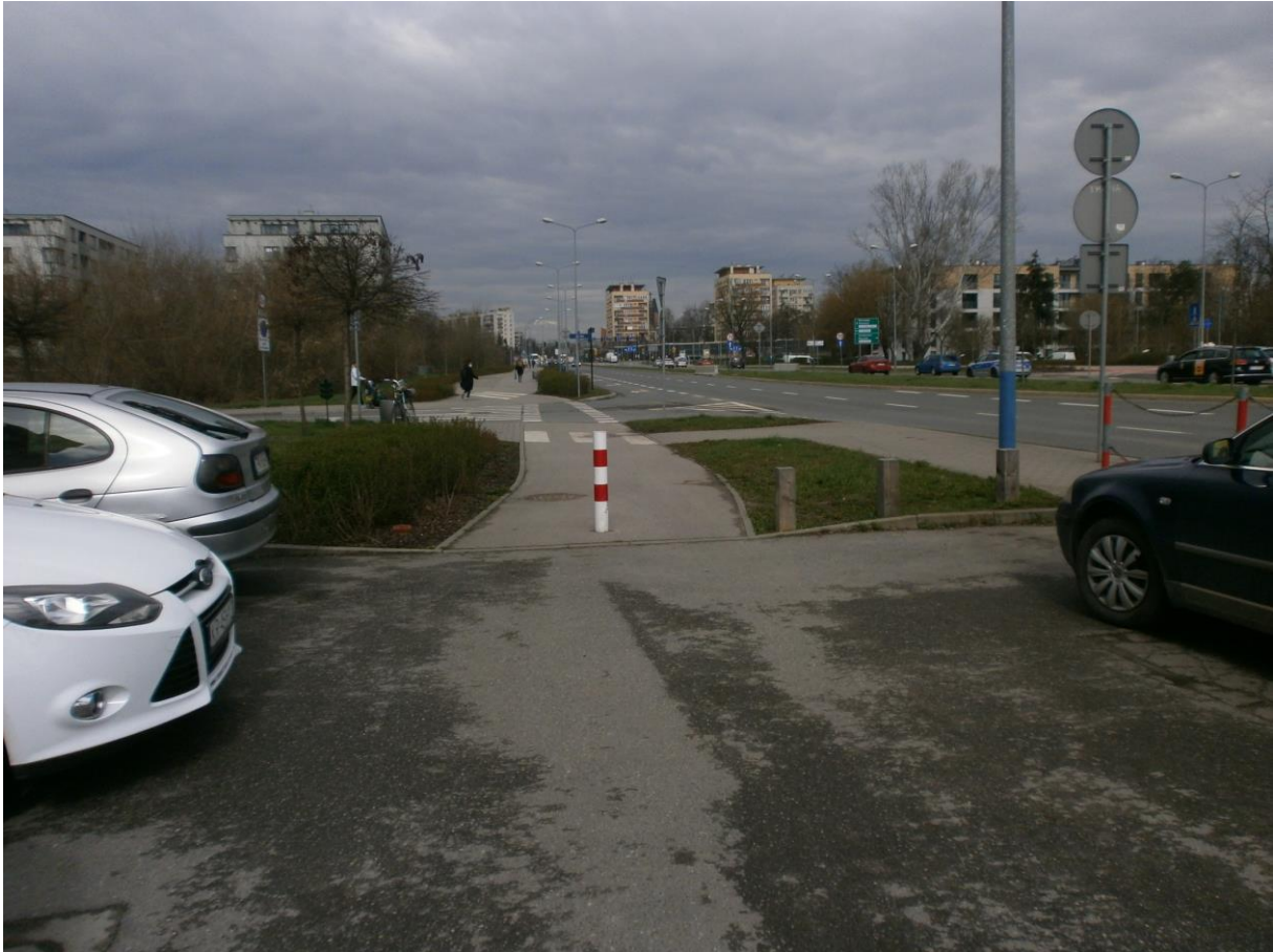
Ilustracja 29. Słupek uniemożliwiający wjazd samochodów na trasę rowerową
