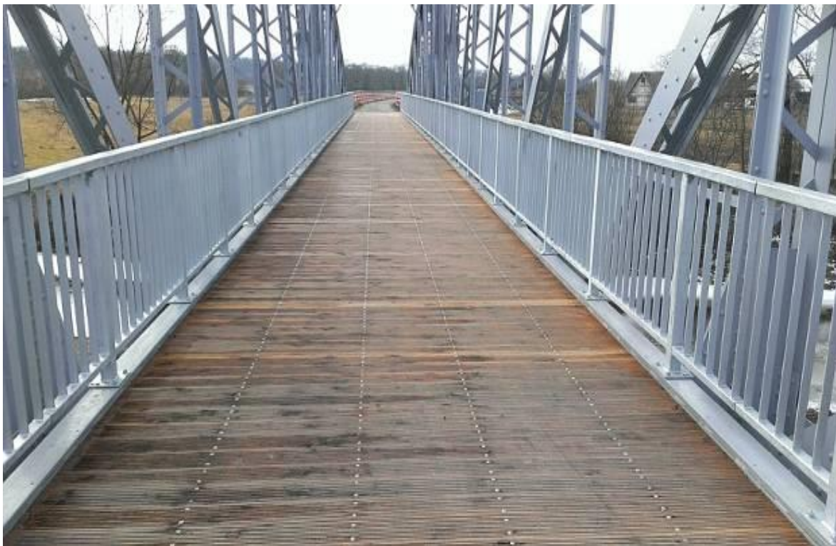
Ilustracja 40. Adaptacja mostu kolejowego na kładkę rowerową
