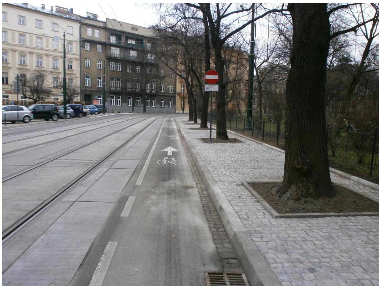
Ilustracja 9. Uspokojona rozcięciem I obwodnica z jednym jednokierunkowym pasem dla samochodów, środek jezdni wyłącznie dla transportu zbiorowego a prawy pas dla rowerzystów
