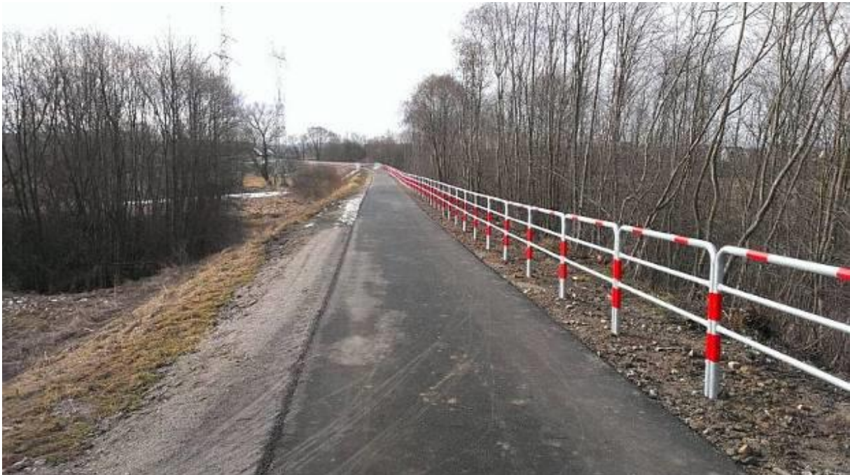
Ilustracja 4. Trasa rowerowa na nasypie dawnej linii kolejowej (niepotrzebnie wprowadzone balustrady)
