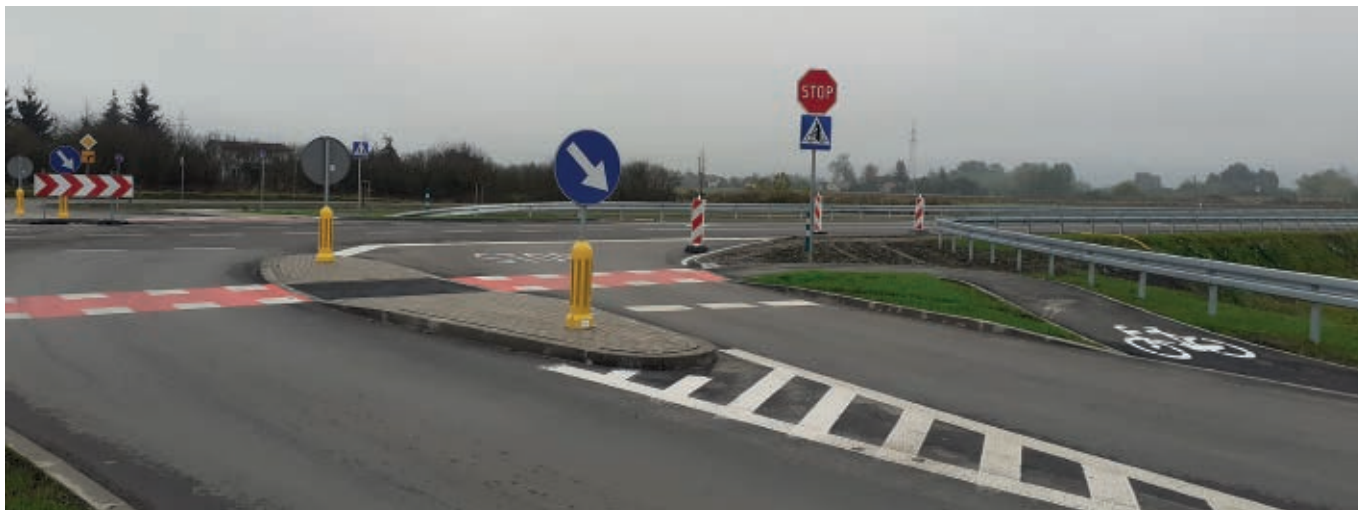
Wjazd na obwodnicę Stężycy w ciągu DW 801, fot. ZDW Lublin
