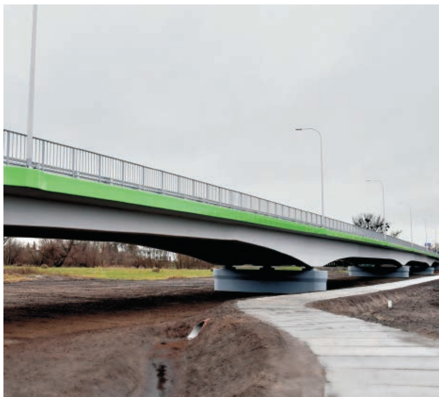
Przebudowany most na rzece Wieprz w Trawninkach, w ciągu DW 838, fot. Piotr Wójcik
