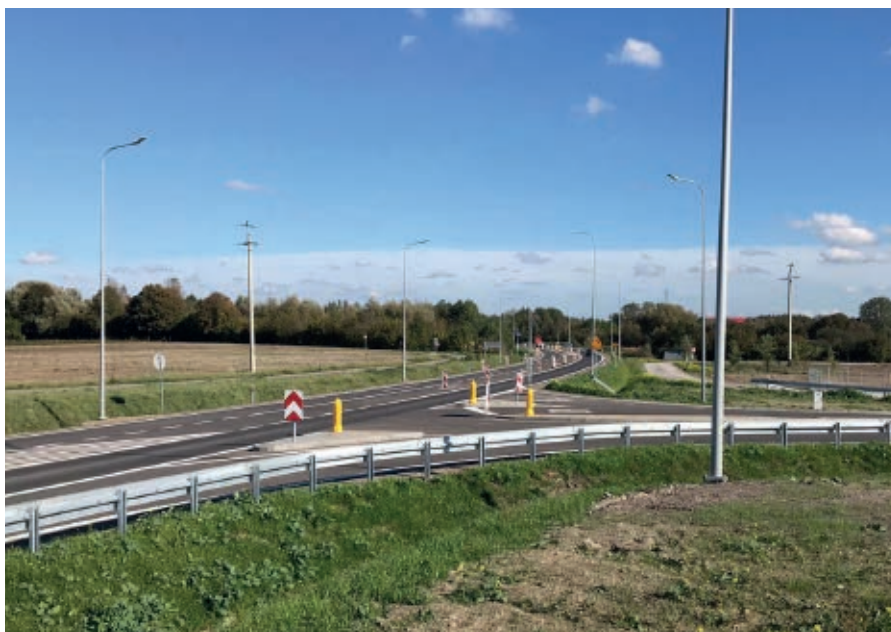
Skrzyżowanie dróg 833 i 747 w Przytykach k. Chodla, fot. archiwum ZDW
