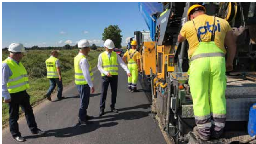
Układanie nawierzchni bitumicznej, fot. Starostwo Powiatowe Biłgoraj
