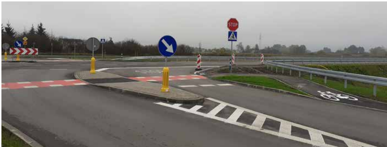
Wjazd na nową obwodnicę Stężycy, fot. ZDW Lublin
